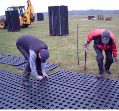
Alignement des plaques au sol
