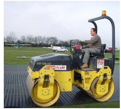
Installation de 3 ou 4 rangées, puis passage du rouleau en laissant la dernière rangée libre
